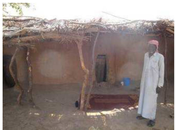
L'homme a ajouté un muret supplémentaire au niveau de la porte d'entrée
