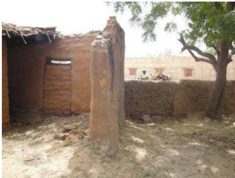
Maison détruite par les inondations au niveau de la place en face de la concession de Manthita Hamet Diawara, et dont les entrées ont été rebouchées avec du banco
